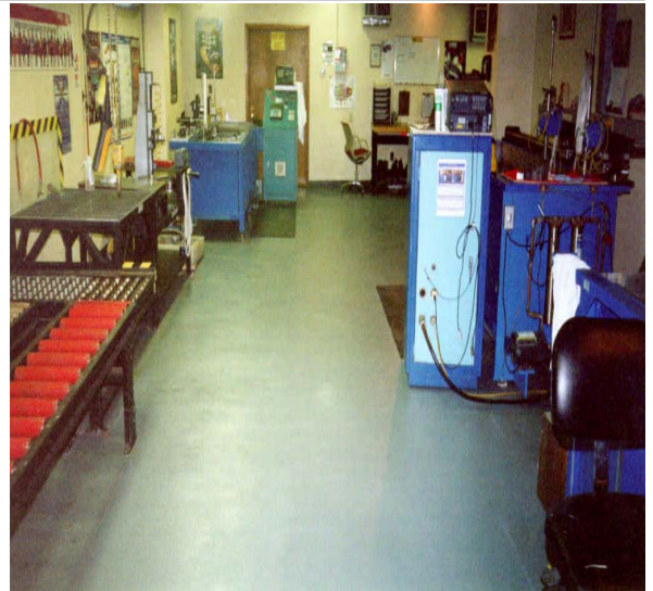
原先老的混凝土地面被修补后面涂上耐磨防化的环氧系统。如今的生产环境安全且舒适。
