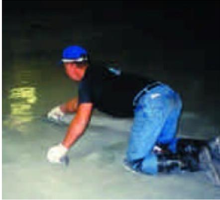
在用电镐去除可口可乐厂房的旧环氧砂浆地坪之后，露出的混凝土基层采用机械方式进行处理。在准备工作就绪以后，由 Stonhard 公司特别培训的安装队伍使用放料车铺设四组份聚氨酯砂浆，并在表面抛砂。之后，还会施工高性能的聚氨酯面涂以提供额外的防化性和耐磨性能。
